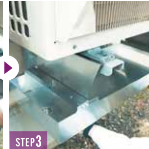
▼ 取付金具にドレンパンをはめ込み設置完了
