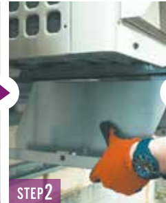
▼ 反対側も取付金具を差し込む
