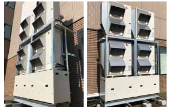
▲ 2段目室外機下部にはヒーター付きドレンパンも組み込み
