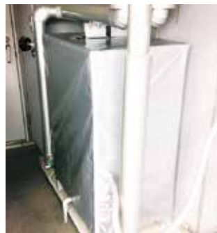
屋外設置防水シート
