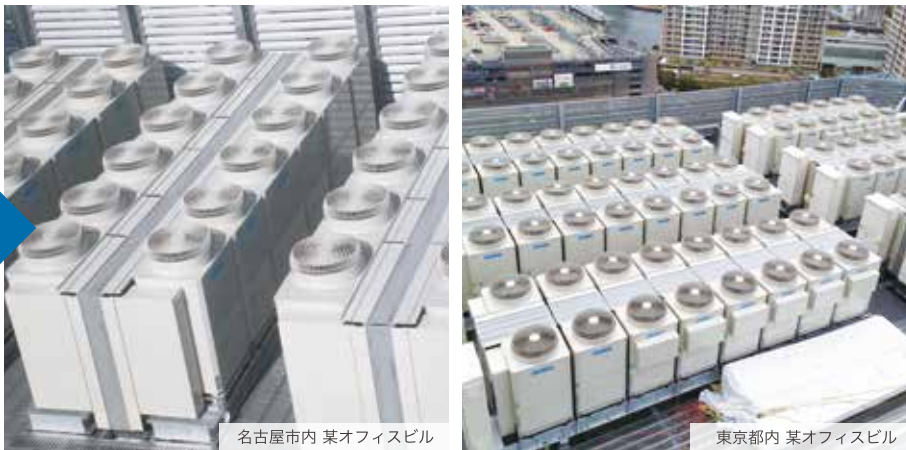
名古屋市内 某オフィスビル
