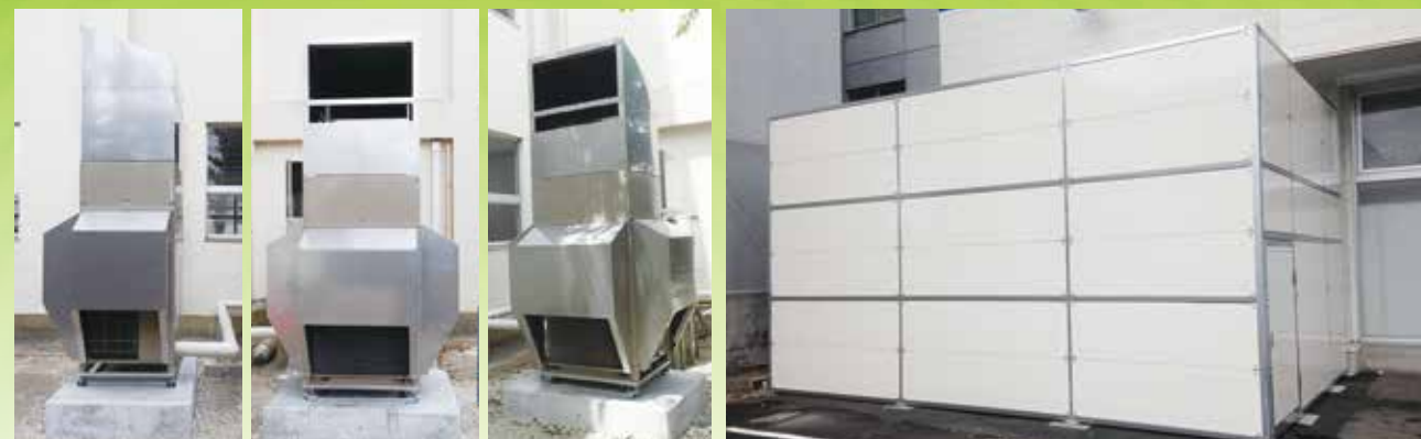
防音防雪フード 背面側薄型仕様 吸込側の防音防雪フードの奥行を変更し、スペースを確保しました。
