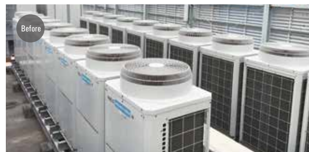
▼ 名古屋市内 某オフィスビル
