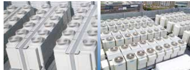
サンシェードの導入によりコンパクトな設置を実現しました。
