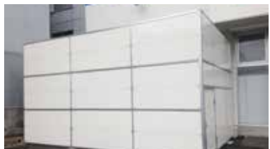
▼ 札幌市内某現場
