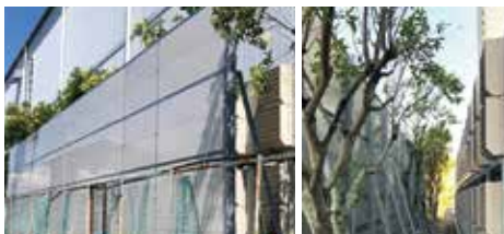
▼ 静岡県内某現場
