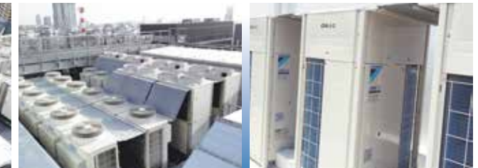
室外機を集団設置する際のショートサーキット対策部材としてご採用頂きました。
