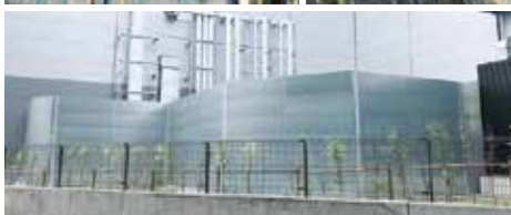
▲ 大阪府某現場
