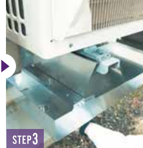
▼ 取付金具にドレンパンをはめ込み設置完了
