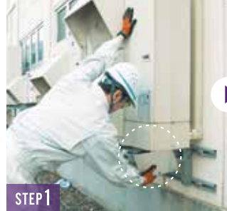
▼ 室外機と架台の間に取付金具を差し込む
