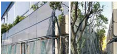
▼ 静岡県内某現場
