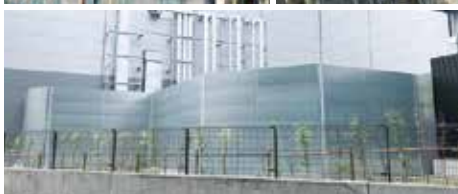
▲ 大阪府某現場
