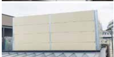
▲ 京都府某現場
