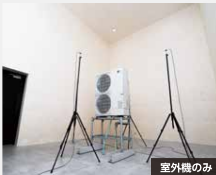
防音システム設置
