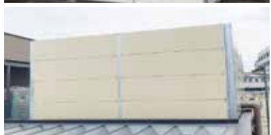
▲ 京都府某現場
