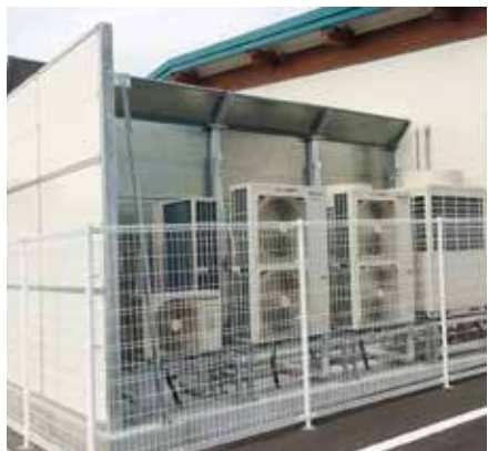
▼ 大分県内某現場
