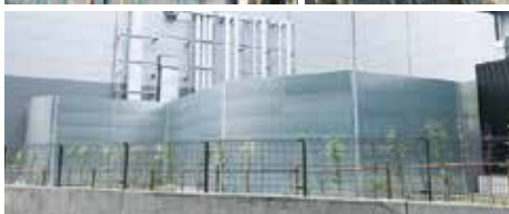
▲ 大阪府某現場
