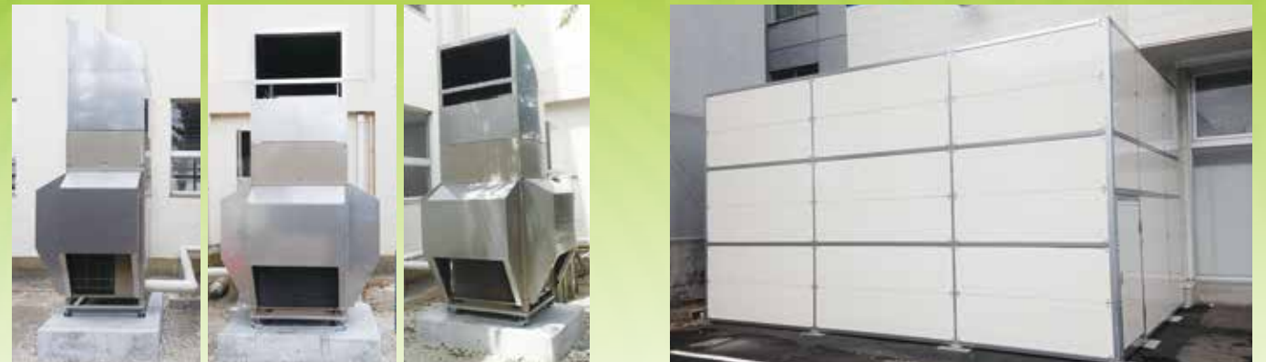
防音防雪フード 背面側薄型仕様 吸込側の防音防雪フードの奥行を変更し、スペースを確保しました。
