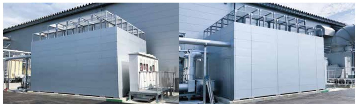
防雪ネット付き防音システム ヘキサゴンフォース5台連結用 防音壁+防音ダクト+防雪ネットがセットになった特注品です。
