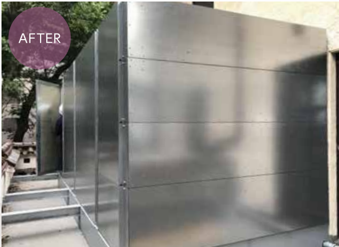
東京都内某現場 EHP用の防音壁としてご採用いただきました。騒音解析を行い、規制値をクリアするよう設計しました。
