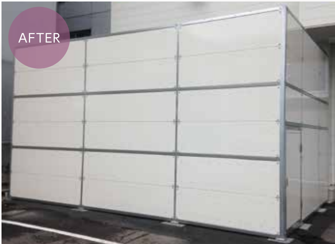
札幌市内某現場 GL設置のGHP用防音壁としてご採用いただきました。側面に防音扉も設置し、メンテナンス性も確保しました。
