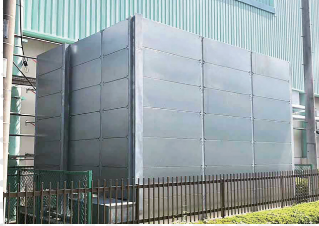
狭小なスペースに高さ3mの遮音壁を設置
