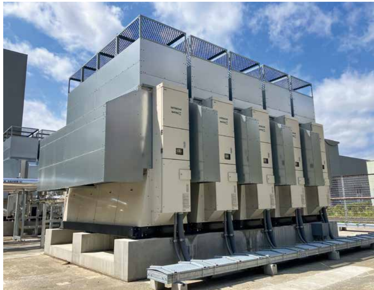
積雪地域向け防音システム(吹出側防雪ネット付き) ※防雪ネットは特注対応となります
