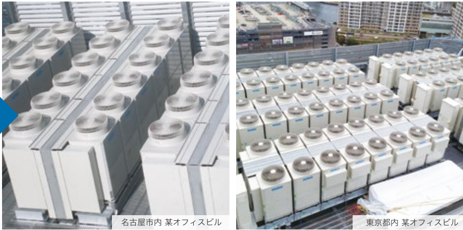
名古屋市内 某オフィスビル
