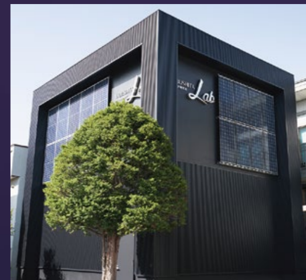
ヤブシタ研究所の半無響音室実験棟。半自由音場である半無響音室で空調室外機の騒音値や防音製品の効果を測定しています。
