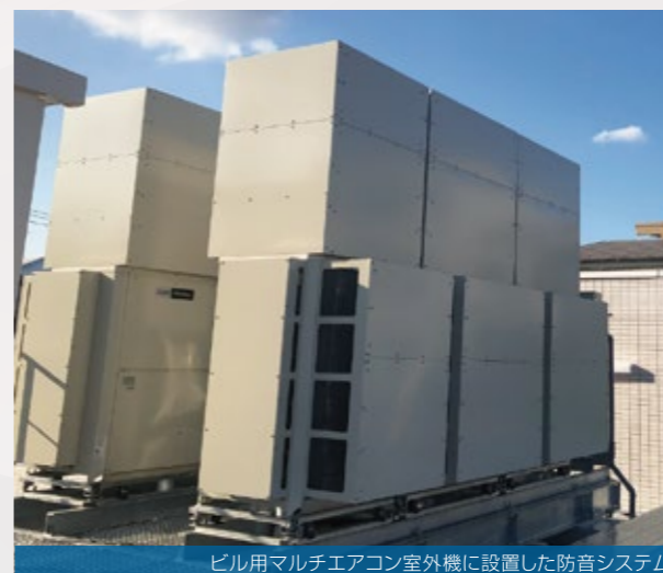
ビル用マルチエアコン室外機に設置した防音システム
