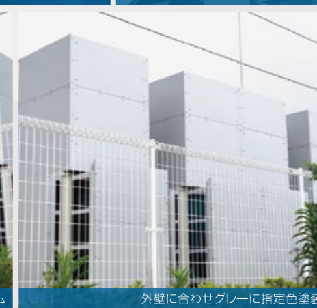
ビル用マルチエアコン室外機に設置した防音システム
