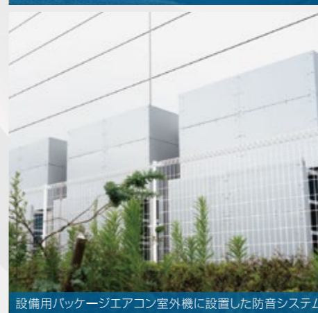
ビル用マルチエアコン室外機に設置した防音システム
