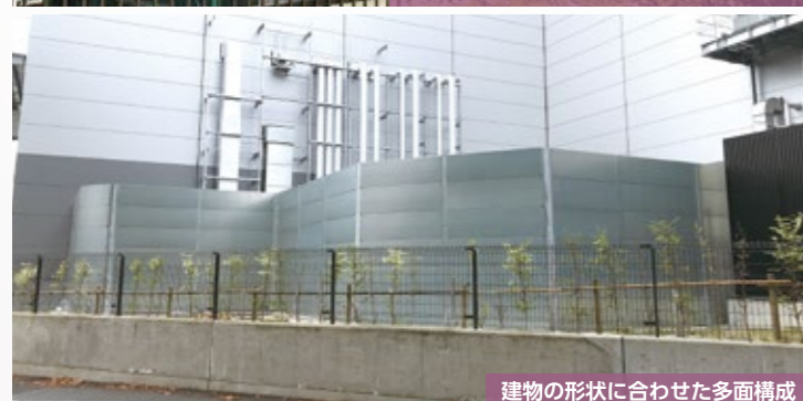
狭小なスペースに高さ3mの遮音壁を設置
