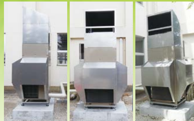
防音防雪フード 背面側薄型仕様 吸込側の防音防雪フードの奥行を変更し、スペースを確保しました。
