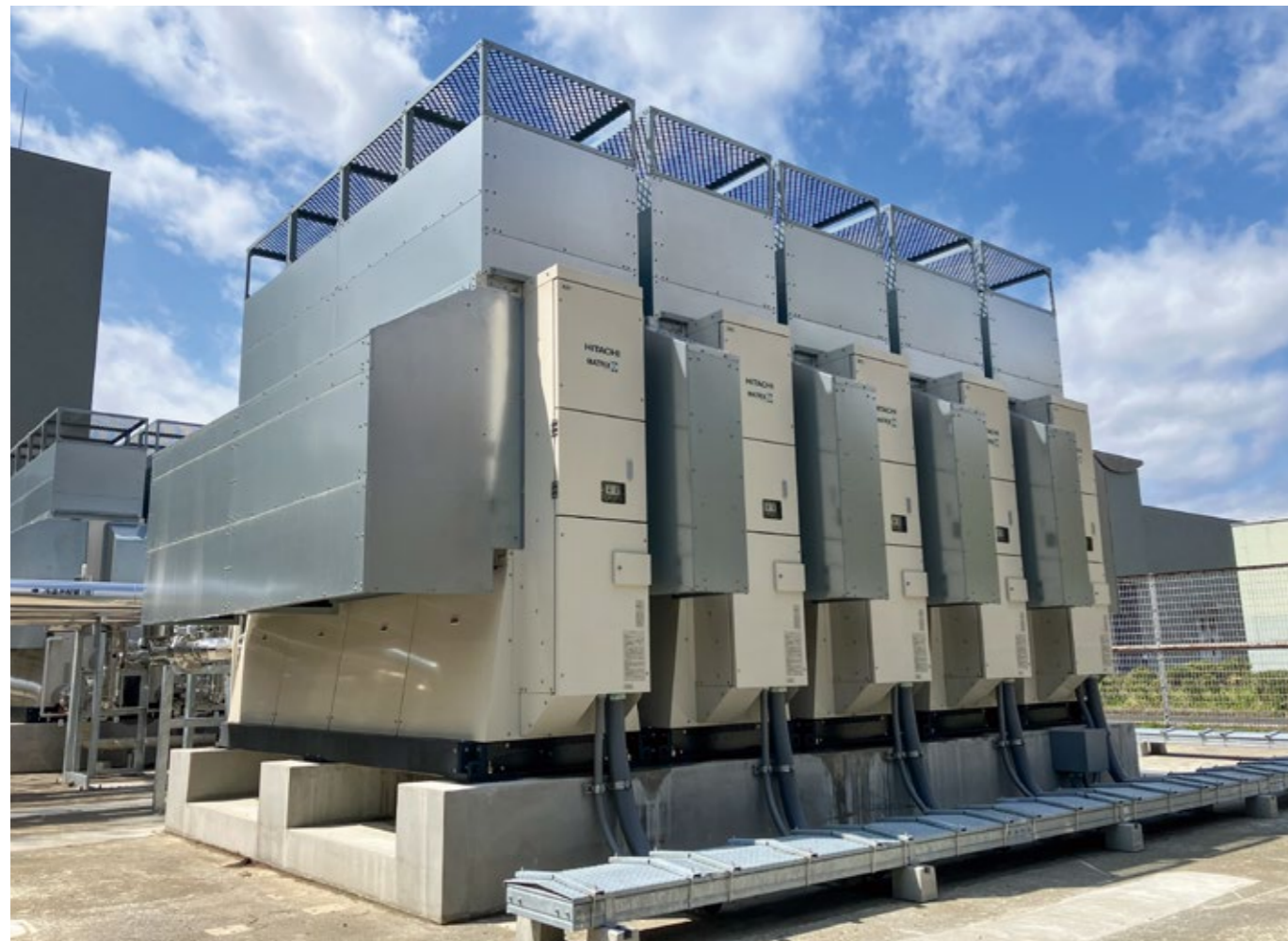
積雪地域向け防音システム(吹出側防雪ネット付き) ※防雪ネットは特注対応となります
