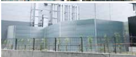
▲ 大阪府某現場
