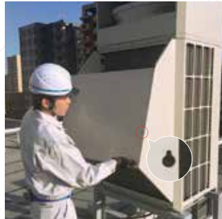
▶工事業の経験を活かし 1 人でも取付が出来るようにビス穴や構造に工夫をしています
