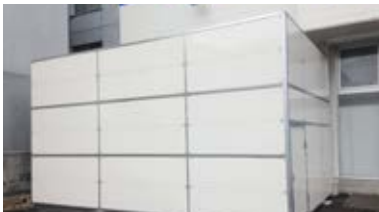
▼ 札幌市内某現場
