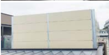
▲ 京都府某現場
