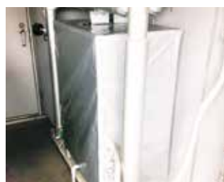
屋外設置防水シート
